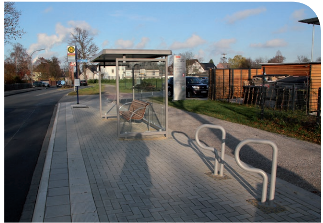
Abb. 12: Muster einer modernen und barrierefrei ausgebauten Haltestelle
